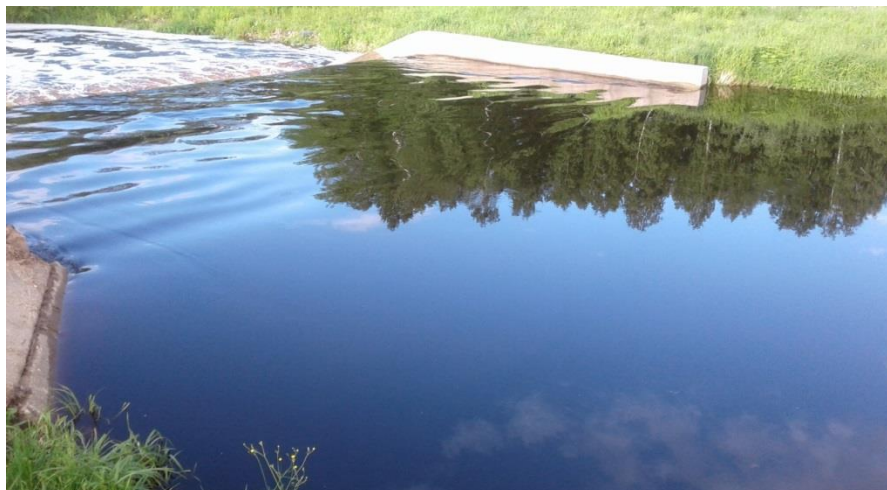
Плотина на реке Мондома
